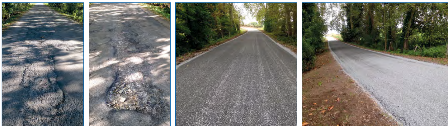
Réfection chaussée - Route de la Croix Blanche (avant et après)
