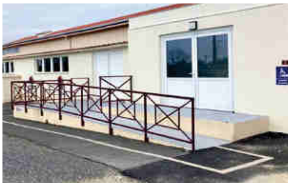
RAMPE D'ACCÈS PERSONNES HANDICAPÉES
