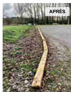
REPLACEMENT DES ANCIENNES TRAVERSES DE CHEMIN DE FER PAR DES TRAVERSES EN CHÊNE SUR TOUT LE POURTOUR DU BOULODROME (240 M LINÉAIRES)
