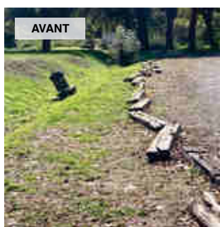
REPLACEMENT DES ANCIENNES TRAVERSES DE CHEMIN DE FER PAR DES TRAVERSES EN CHÊNE SUR TOUT LE POURTOUR DU BOULODROME (240 M LINÉAIRES)
