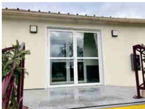
CHANGEMENT DE LA PORTE D'ENTRÉE
