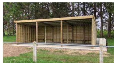
Abri ossature bois de 60 m², sur socle bétonné, avec bancs intérieurs sur tout le pourtour, à destination des joueurs et familles durant les tournois, matches et entraînements. Engazonnement en cours.
