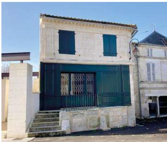
Les différents travaux sont terminés. La façade en pierre a été nettoyée et de nombreuses pierres remplacées. La façade bois a été repeinte et les dalles d'eaux pluviales remplacées. Coût total : 22 000 €.
