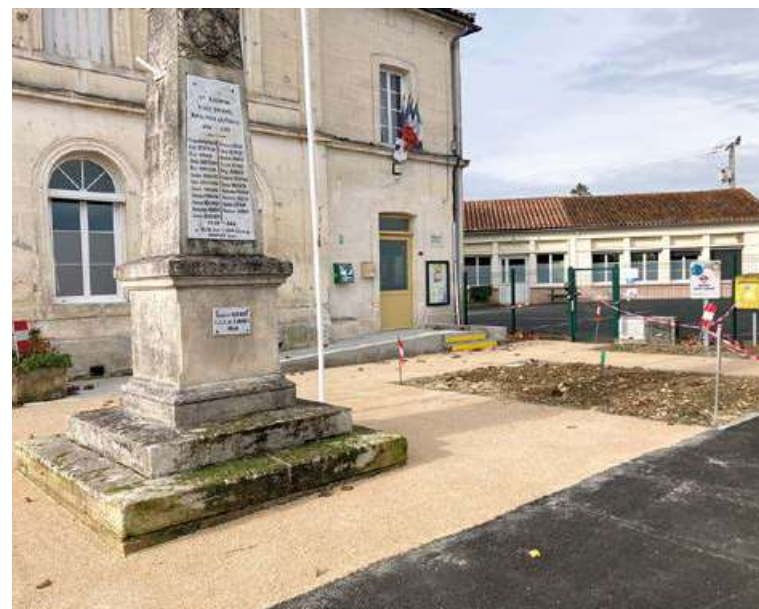
Aménagement de la place (en attente des espaces verts et arborés).
