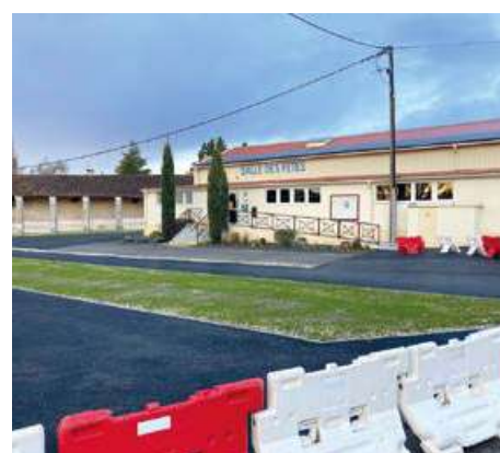
Aménagement parking de la salle des fêtes (Première tranche fin 2025 - Deuxième tranche programmée en 2026).
