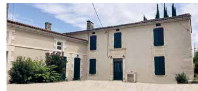
Mise en peinture des volets et portes du presbytère et de la sacristie
