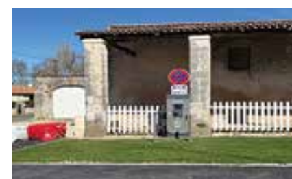
Installation de candélabres à led et mise en service de la borne de recharge électrique.
